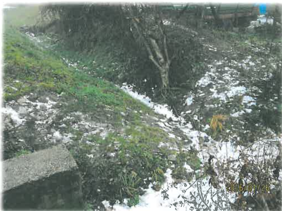
6. kép: a földárok becsatlakozása a befogadóba
