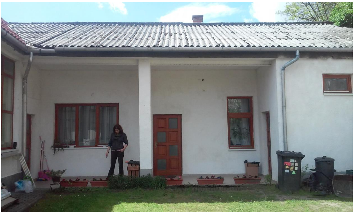
Előregedett azbeszt hullámpala fedés
