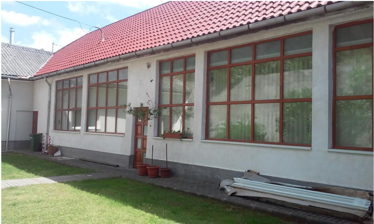
Azbeszt hullámpalával fedett tetősík (kép baloldalán látható)
