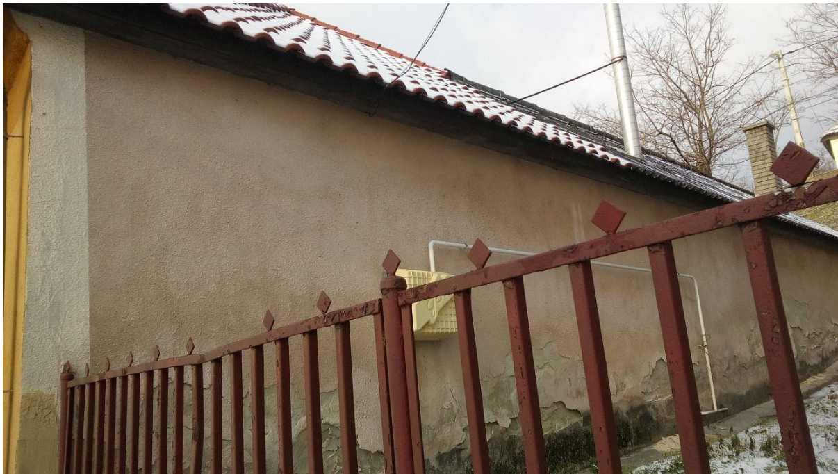
Azbeszt hullámpala és tetőcserép fedésének határvonala
